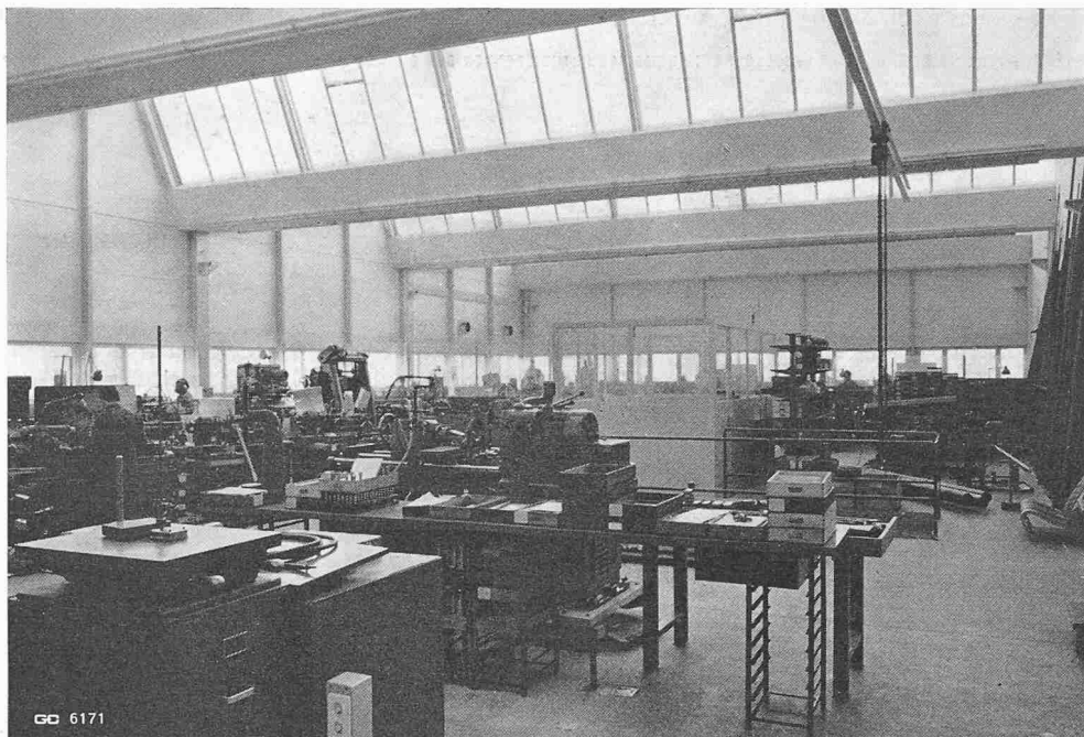
Bild 3. Einschiffige Shedhalle. Rinnen als Rahmenriegel mit Rahmenknoten (durch Isolation verdeckt) mit den Stützen verbunden. (Halle für Firma H. Kaiser, Rümlang)
