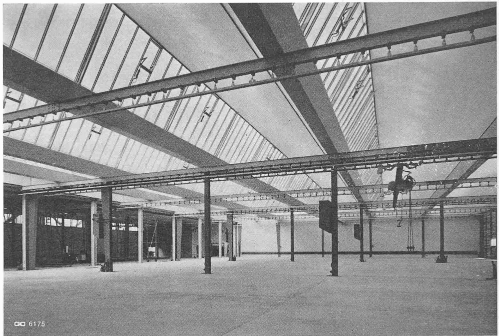
Bild 7. Innenansicht einer mehrschiffigen Halle. Die Zugbänder sind durch Hängekranträger ersetzt. (Shedhalle für Firma Rieter AG., Winterthur)
