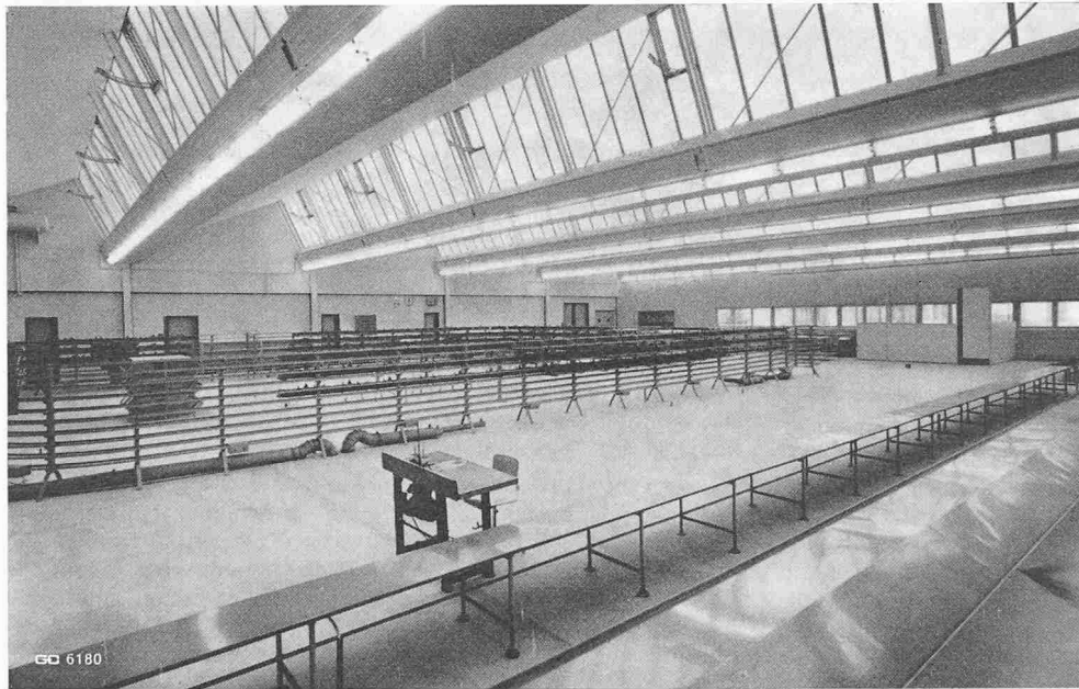
Bild 15. Stützenfreie Halle mit 25 m Spannweite. (Schuhfabrik Wettingen AG)
