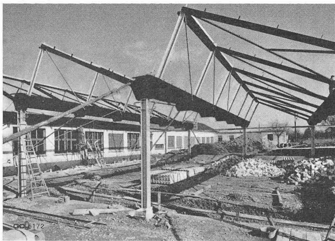
Bild 4. Montage eines Faltwerkes (Halle für Pressta AG., Kesswil)
