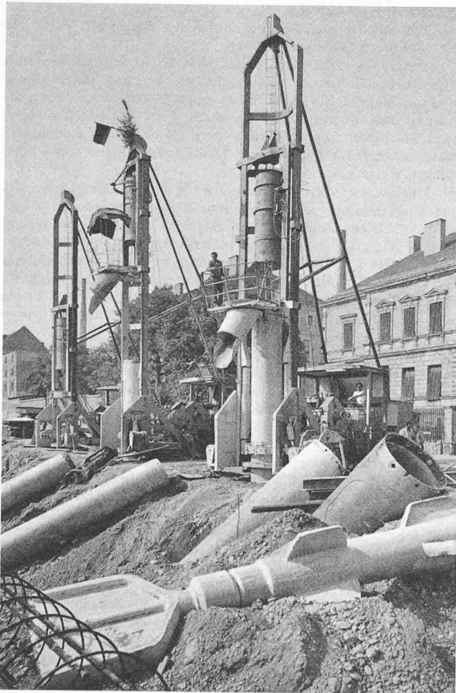
Bild 1. Benoto-Bohrpfahlmaschine EDF 55
