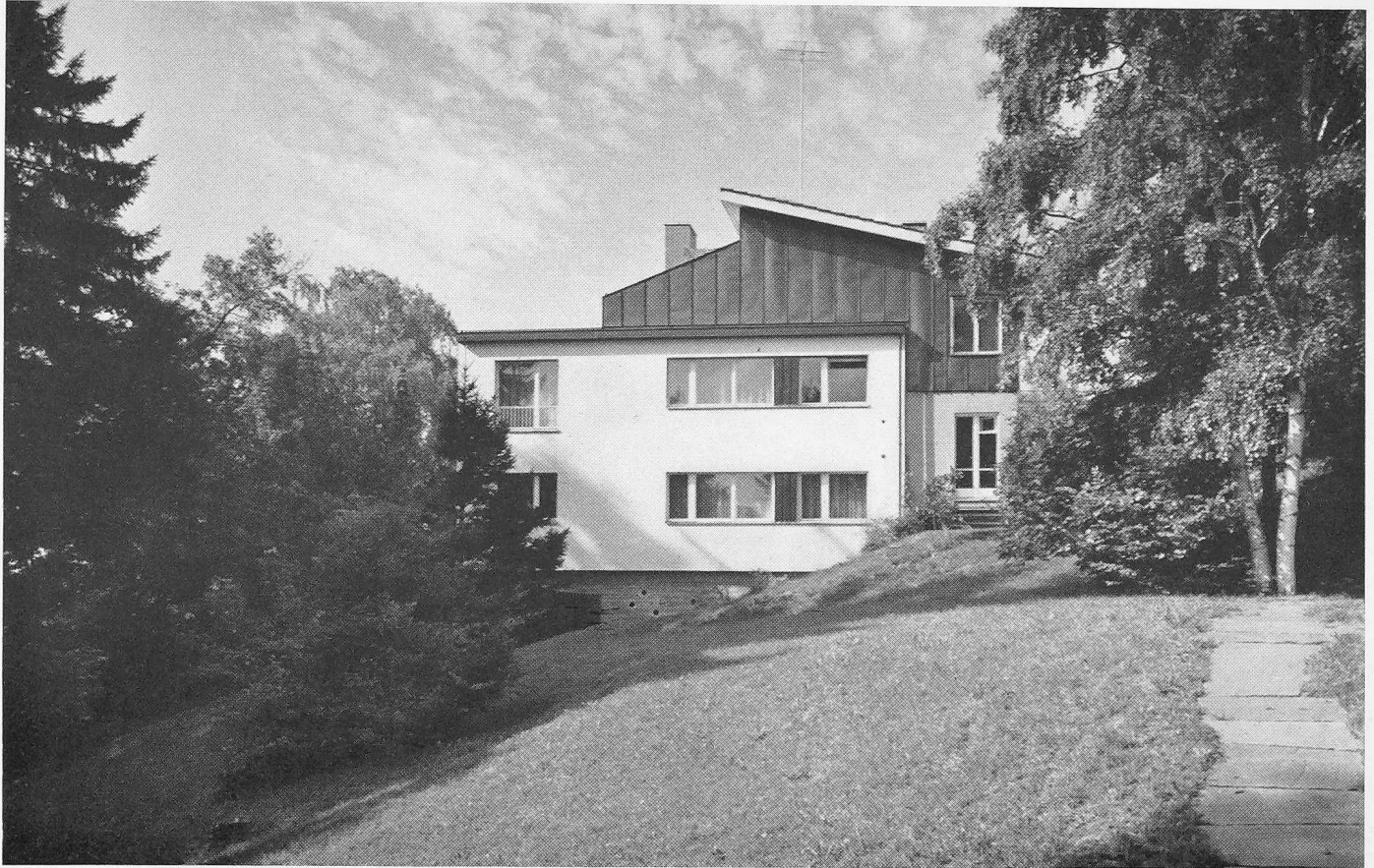
Gesamtansicht aus Süden
