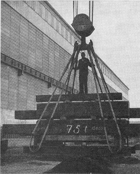
Bild 27. Traggestell zur Aufnahme der Gewichte für die Probebelastung
