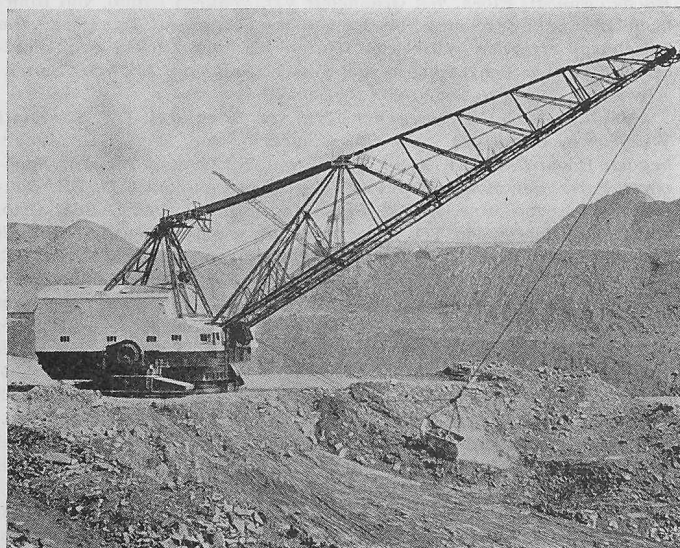
Schürfkübelbagger von Ransomes & Rapier
