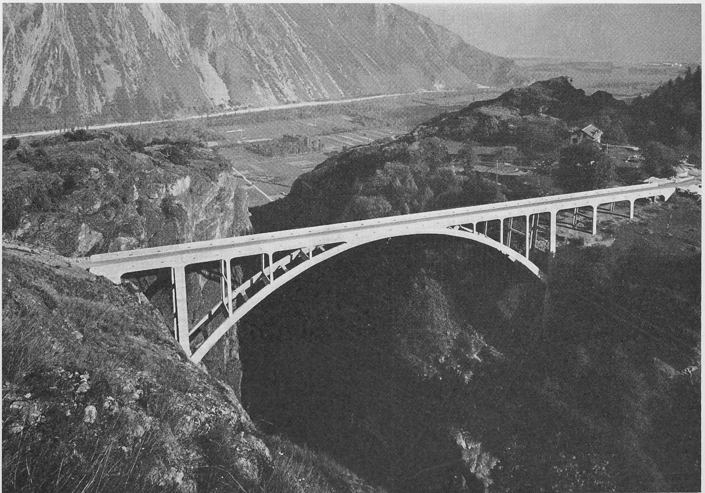
Bild 11. Brücke über den Trient bei Gueuroz (Wallis) von Ing. A. Sarrasin, 1933. Einfaches Beispiel für die Uebereinstimmung von Gehalt und Gestalt. Nicht «form follows function», sondern Lösung des technischen und des ästhetischen Problems aus dem selben Geist, Form und Funktion werden zu einer Einheit
