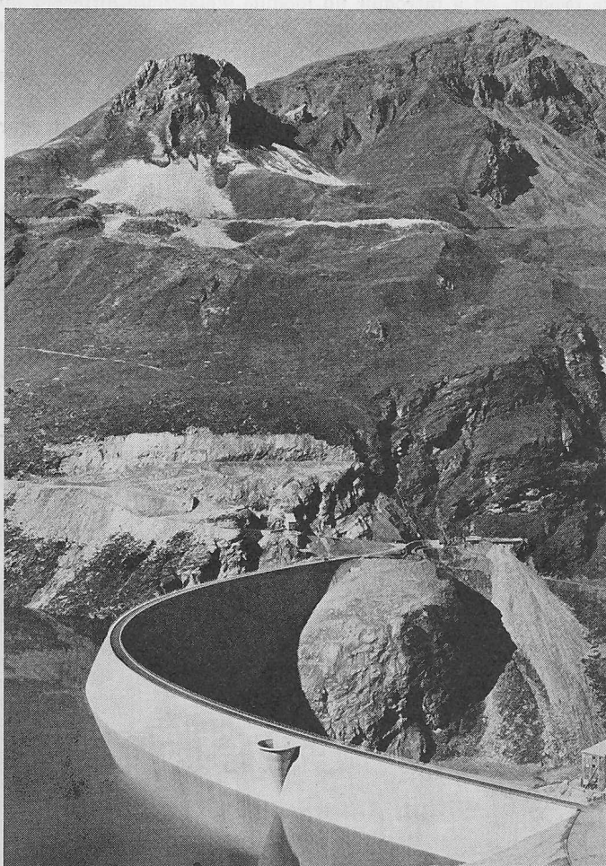
Fig. 8. Le barrage achevé (avant la remise en état des lieux)
