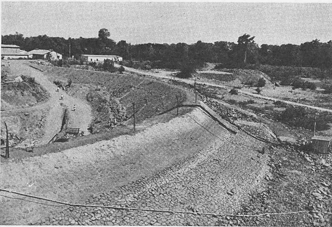
Bild 10. Unterwasserseitiger Fangdamm während der Niederwasserperiode im April 1961
