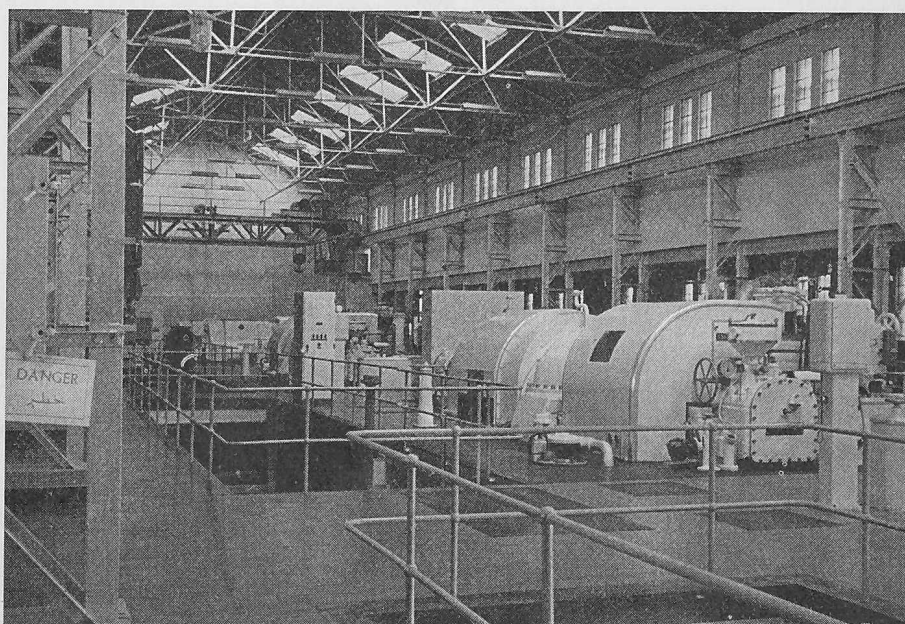
Bild 6. Kraftwerk Burri, neue 10-kV-Einheit
