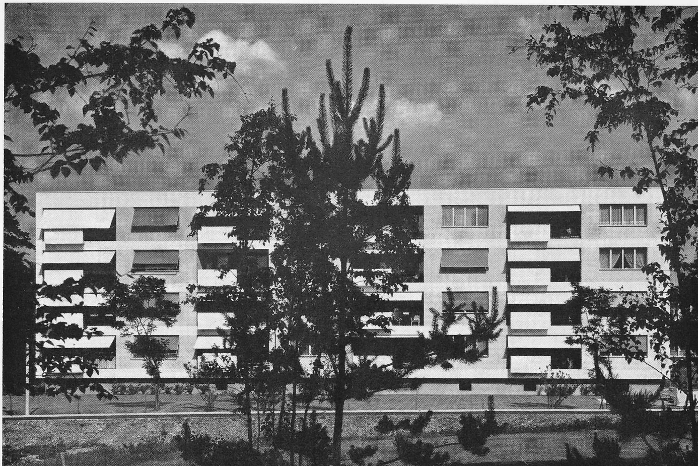
Mehrfamilienhaus an der Gellertstrasse, Ansicht aus Westen
