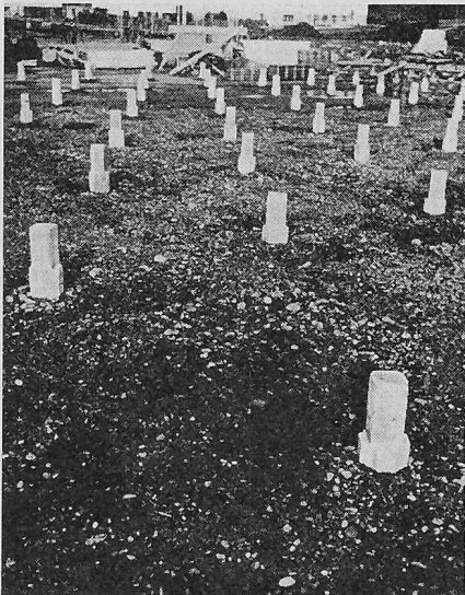
Bild 7, Pfahlköpfe nach Versetzen der Pfähle
