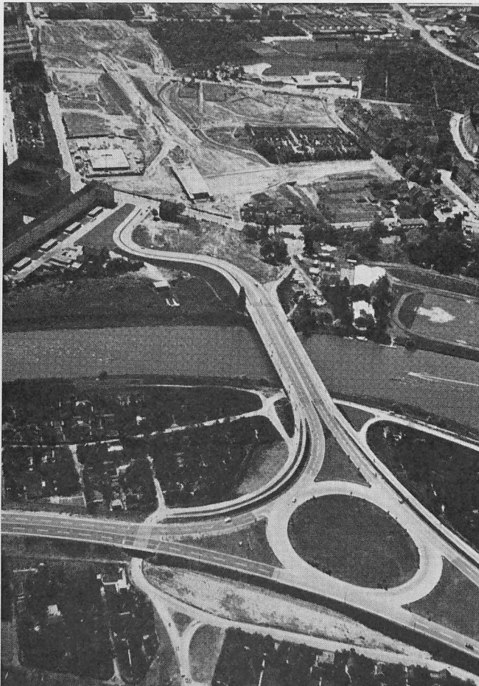
Der Westschnellweg (über die Brücke) im Bau; im Vordergrund links der Westzubringer Richtung Königswortherplatz
