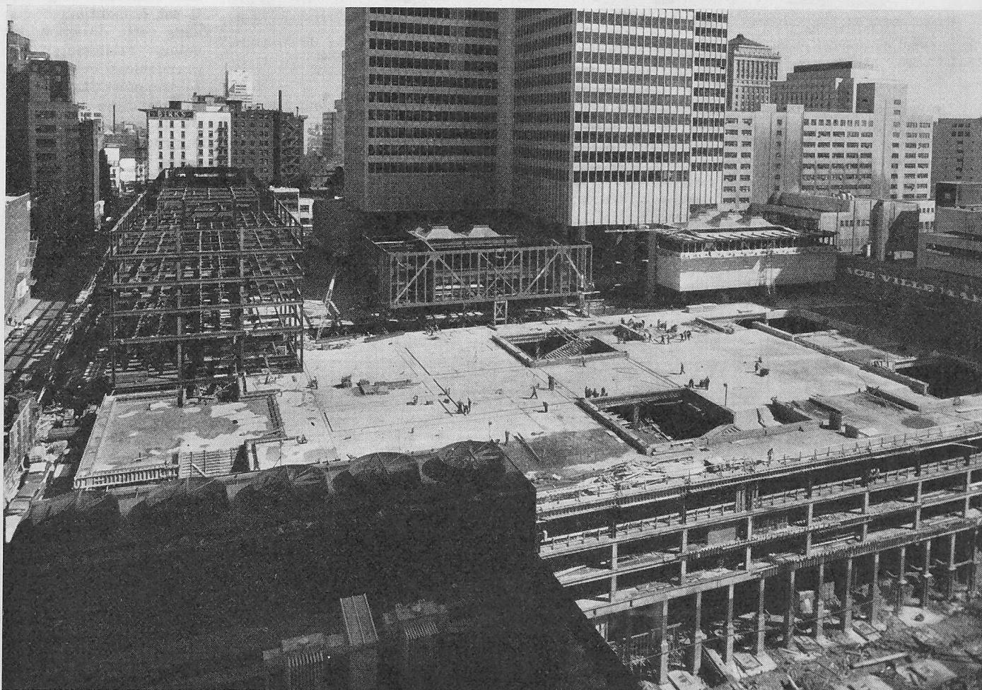
Fig. 14. Vue du projet en septembre 1961, montrant la construction des pavillons ouest à différents stades
