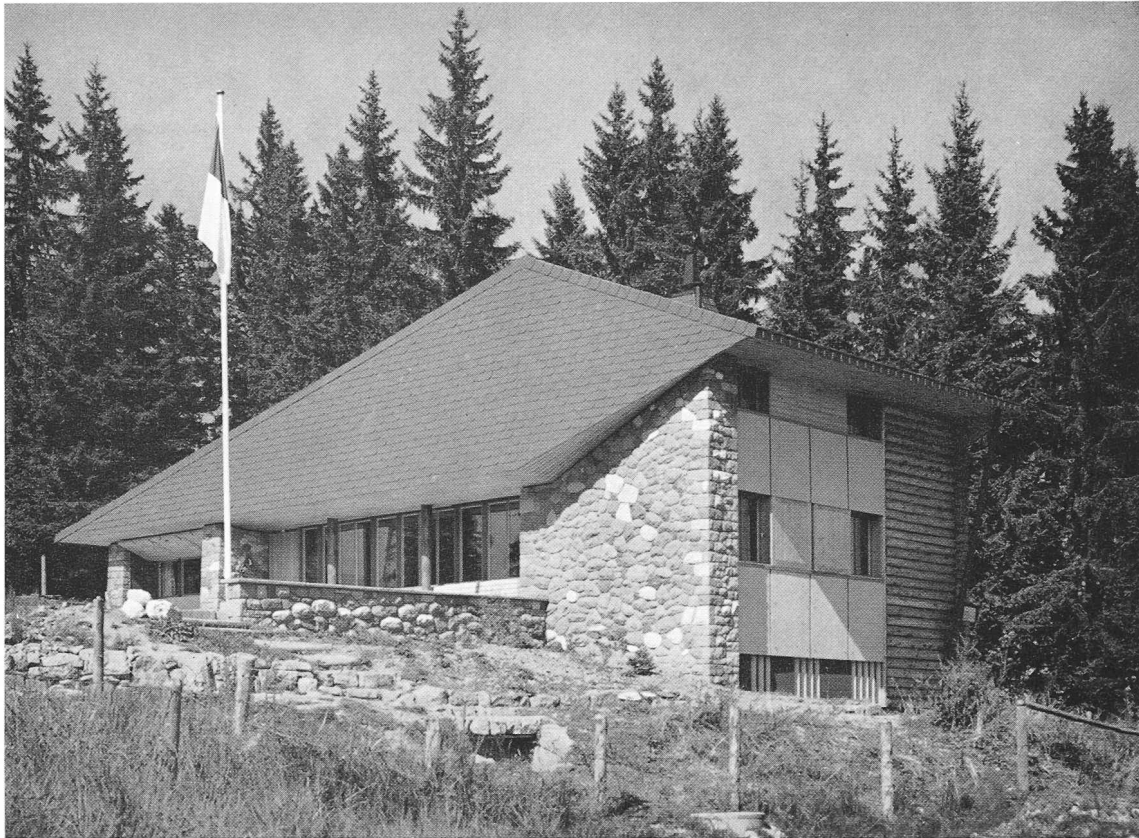
Ansicht aus Südosten
