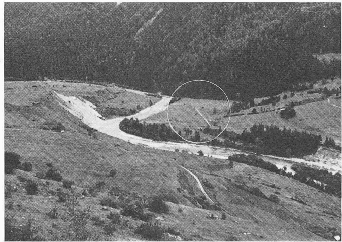
Bild 9. Blick auf die zukünftige Baustelle des Maschinenhauses Pradella
