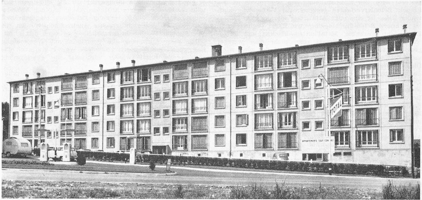
Bild 36. Wohnbaufassade mit Grosstafeln, System Coignet
