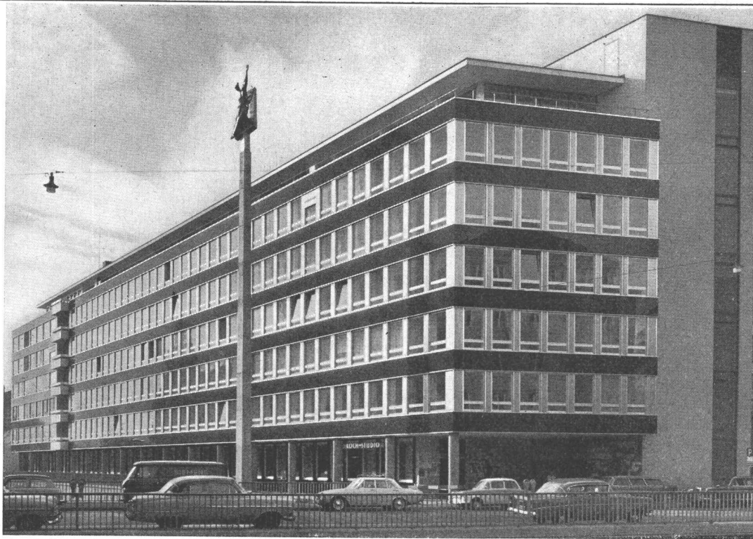
Geschäfts- und Verwaltungshaus der Schweiz. Versicherungs-Anstalt, Zürich Architekt: Dr. Roland Rohn, BSA/SIA, Zürich
