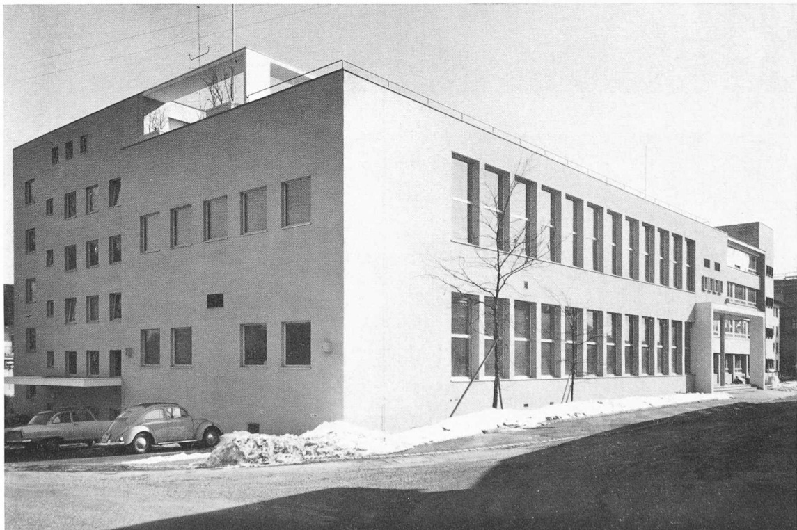
Ansicht aus Nordwesten
