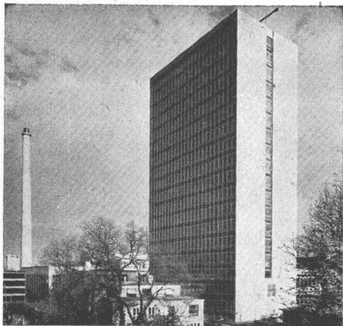
Im Hochbau für hohe Festigkeiten
