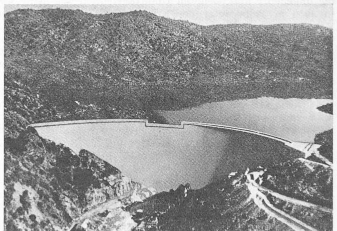
Bild 2. Staumauer Malpasset vor dem Bruch
