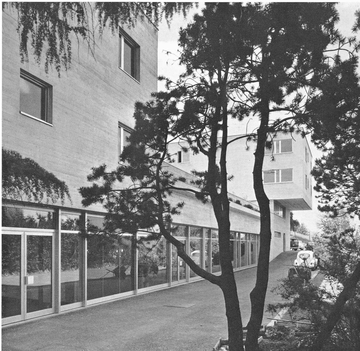
Nervensanatorium in Kilchberg ZH. Ostansicht (Seeseite) der Patientenhäuser E (im Vordergrund) und F mit eingeschossigem Verbindungstrakt (Saalbau)
