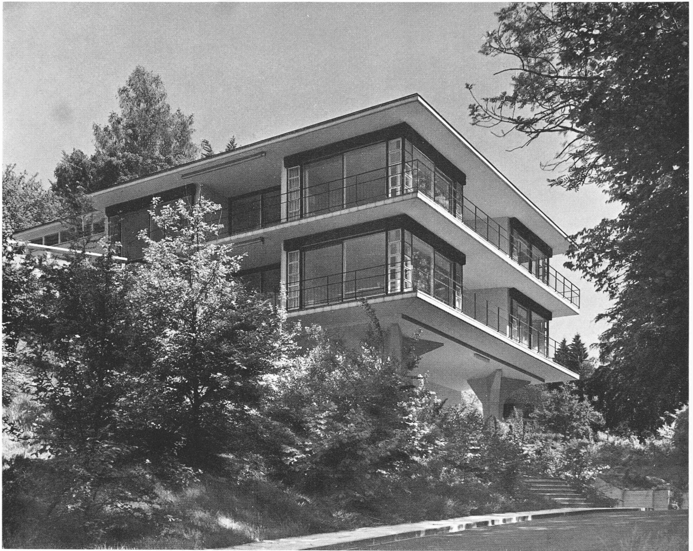
Haus Steiger, Zürich. Ansicht aus Süden
