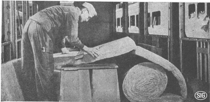
ULTRALITE Isoliermatte, langfaserig, erschütterungsfest und unbrennbar
