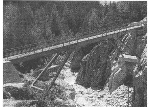
Pont-route de Gebidem →
