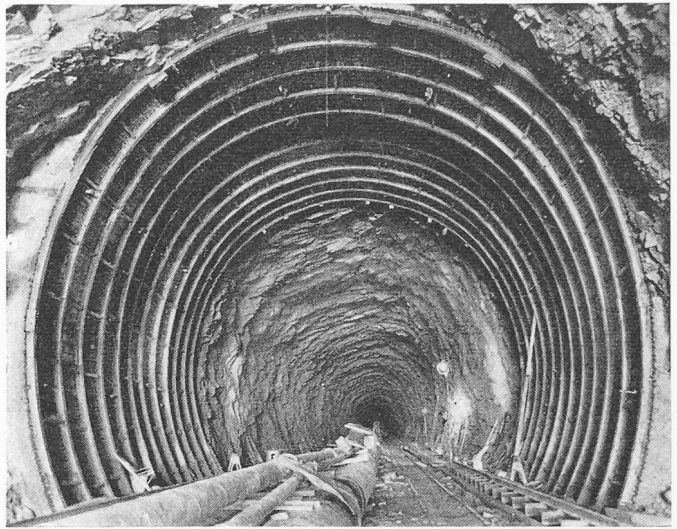
Bild 4. Stahleinbau, vollständig hinterbetoniert, in einer Mylonitzone im Los Nord (Photo Rieser, Mesocco)
