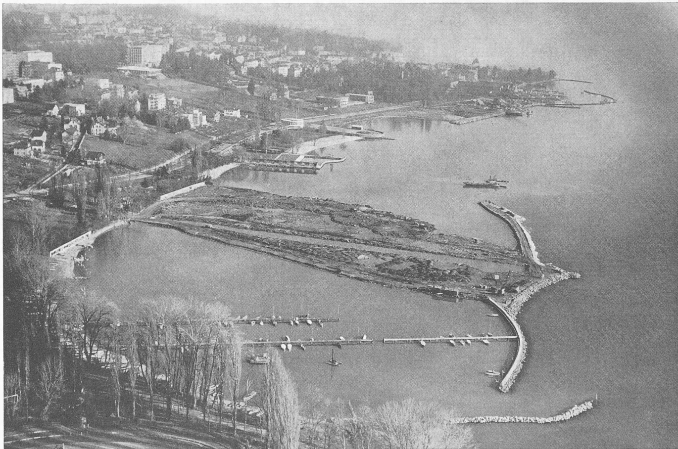
Bild 2. Stand der Arbeiten am 1. Februar 1960, aus Westen. Im Vordergrund der alte Hafen von Vidy, dahinter die Auffüllung, geschützt durch die neue Mole und den neu geschütteten Strand. Der in der Auffüllung offen gelassene Graben ist bestimmt für einen Entlastungskanal für Gewitterregen Photo Aéroport Lausanne
