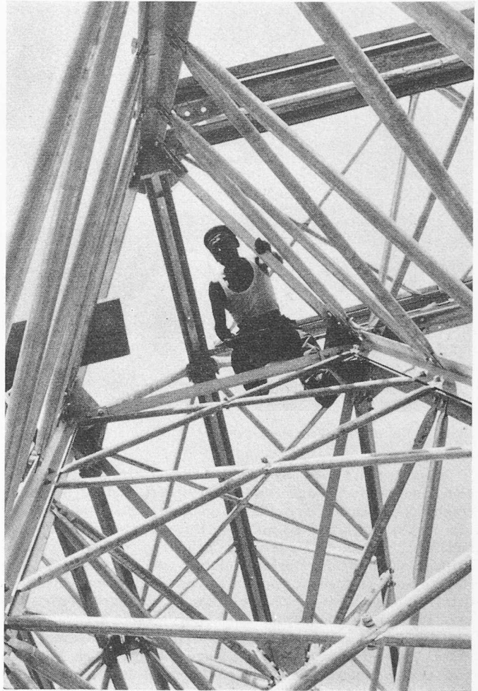
Bild 9. Innenbild einer Rahmenecke, das die konstruktive Ausbildung (Anschluss der Rohrstreben und Windverbände an die Gurtungen) zeigt.
