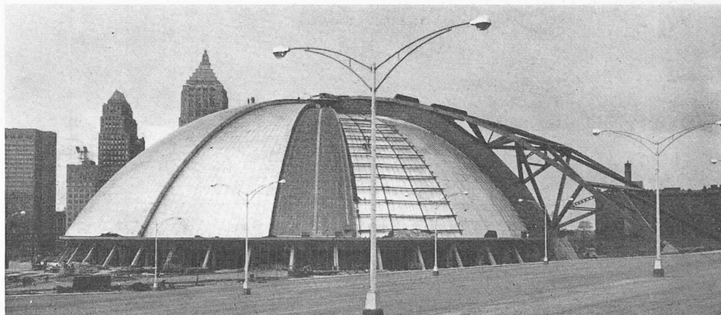
Vue d'ensemble de l'auditorium de Pittsburgh
