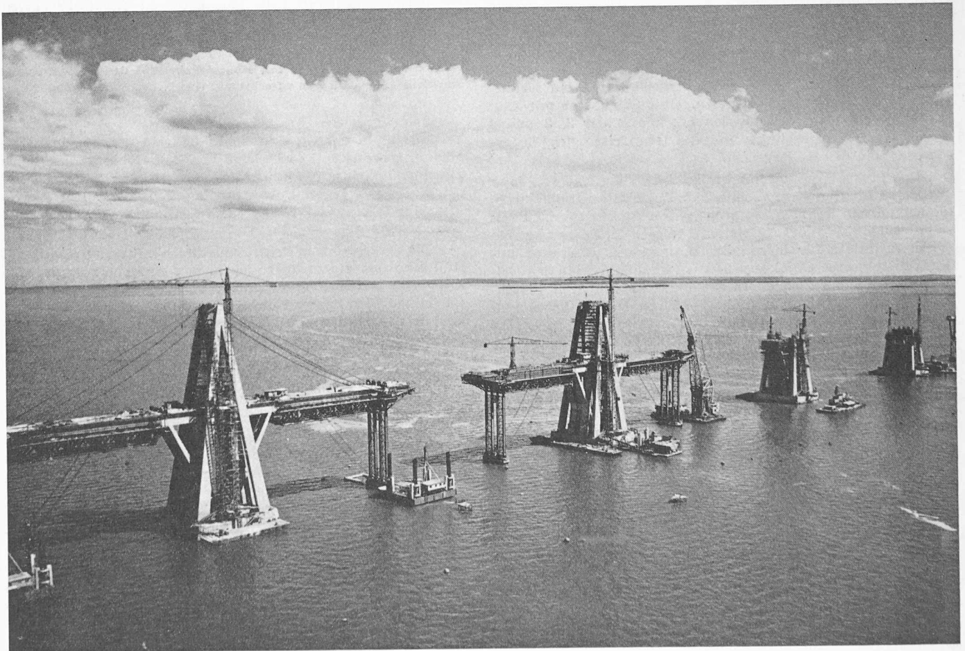
Bild 1. Brücke über den Maracaibo-See, Bauzustände von je 235 m. Die beidseits der Stützenkonstruktion auskragenden Auslegerbalken wurden auf provisorisch abgestützten Schalungsträgern betoniert, da sie erst durch das Spannen der Hängekabel ihre Tragfunktion erhielten
