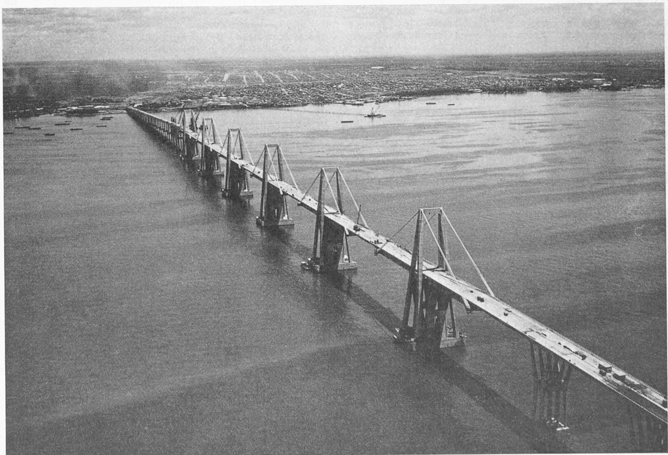
Bild 2. Brücke über den Maracaibosee, Flugaufnahme des fertigen Bauwerks. Im Vordergrund die fünf Mittelöffnungen von je 235 m, im Hintergrund die Stadt Maracaibo (etwa 500 000 Einwohner)
