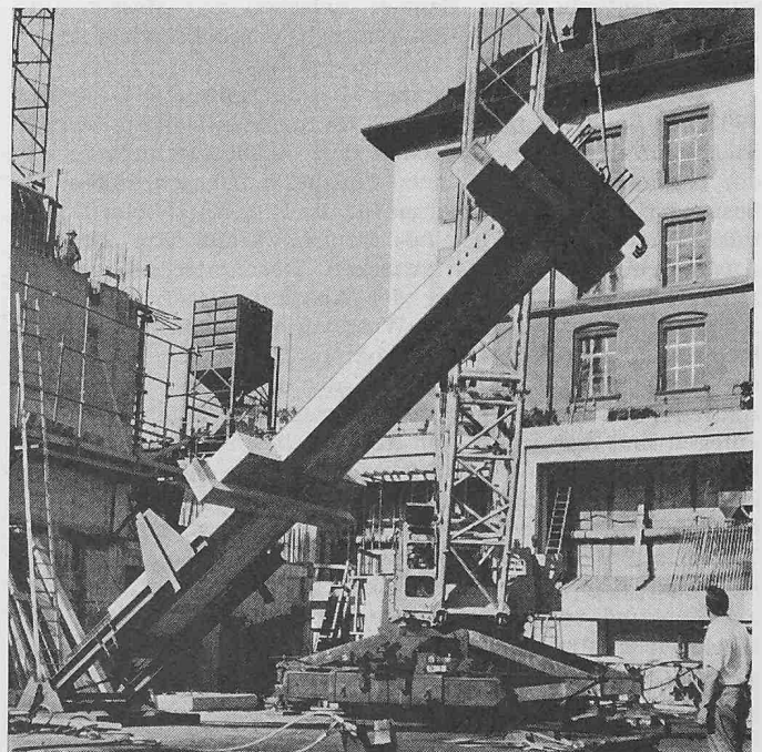
Bild 37. Aufrichten einer Kellerstütze durch den 60-t-Mobilkran
