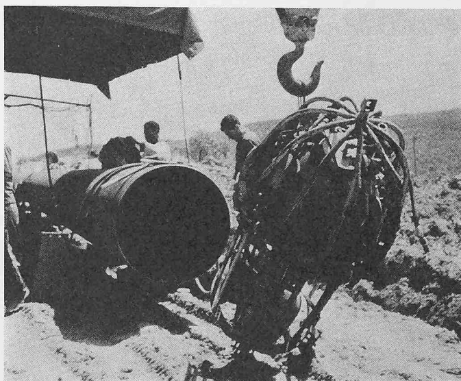
Spannvorrichtung zum Ausrichten zweier aneinanderzuschweisenden Rohre
