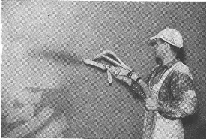
ULTRAPLAST-Sandspachtelfarbe wird mit speziell dafür entwickelten Geräten aufgespritzt, was Tagesleistungen von 500-600 m 2 ermöglicht - eine Durchschnitzzahl, nicht etwa Höchstwerte.
