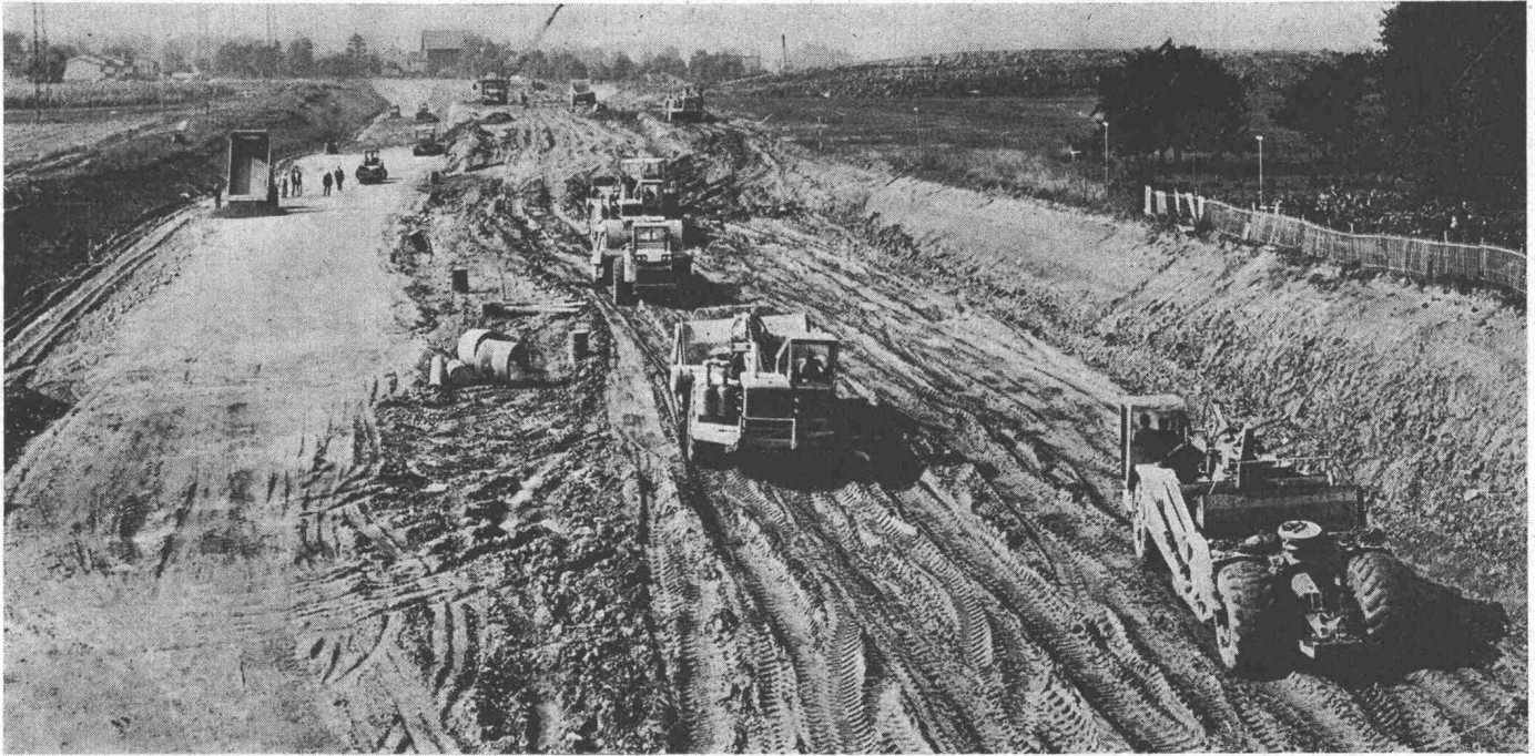
AUTOBAHN GENÈVE-LAUSANNE Anfangsstrecke des Genfer Abschnittes
