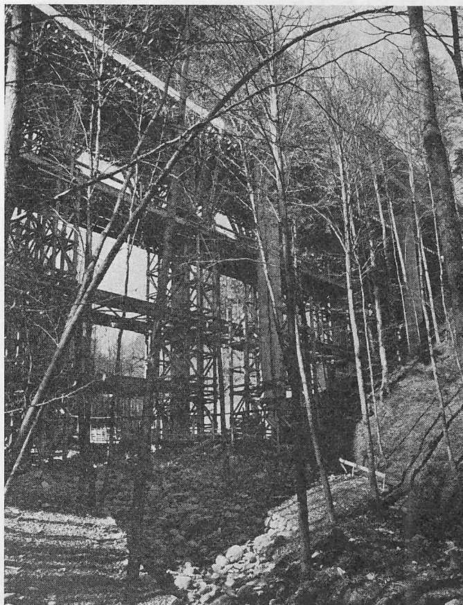
Bild 1 (rechts). Ansicht der Brücke vom Wanderweg aus durch das Mühltobel. Grosse Spannweiten wären hier zu aufwendig
