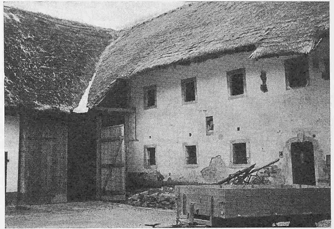
Innenansicht des Oekonomieteiles eines Vierkanthofes in Wilhering
