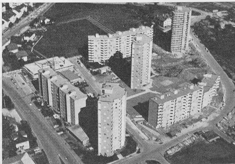
Überbauung JURINTRA AG in Biel-Mett. Drei Hochhäuser zu 16 Stockwerken, drei Scheibenhäuser neugeschossig. Zweischalenmauerwerk 30 cm mit tragender Schalung 15 cm MS innen, 3 cm Mineralwellplattenisolation und äusserer Schale 12 cm MS (Mauerwerk-Sonderqualität)
