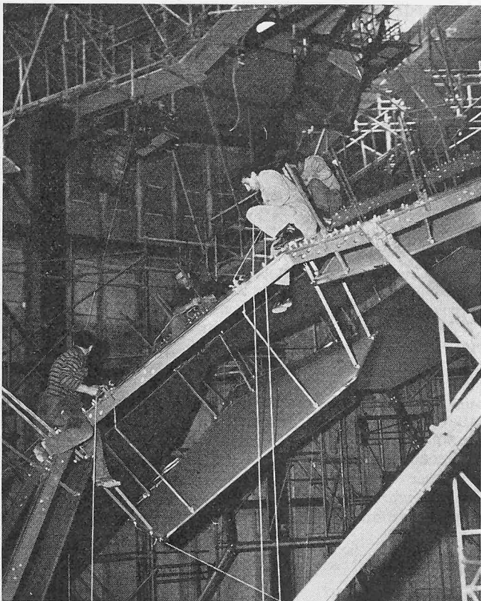
Die Ausrüstung der Projektionskuppel im Aufbau
