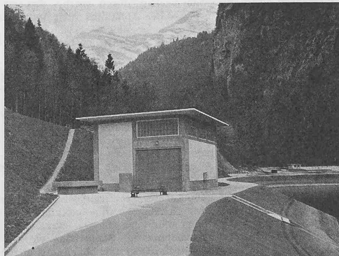
Bild 7. Nebenkraftwerk am Ufer des Ausgleichbeckens für das Kraftwerk Dallenwil
