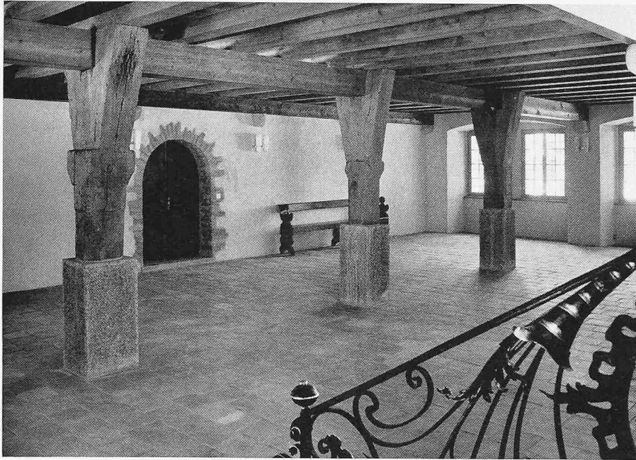
Eingangshalle 1964 (ursprünglich kleines Kaufhaus). Säulen und Bogentüre um 1500. Treppengeländer 1762. Tonplattenboden und Decke erneuert
