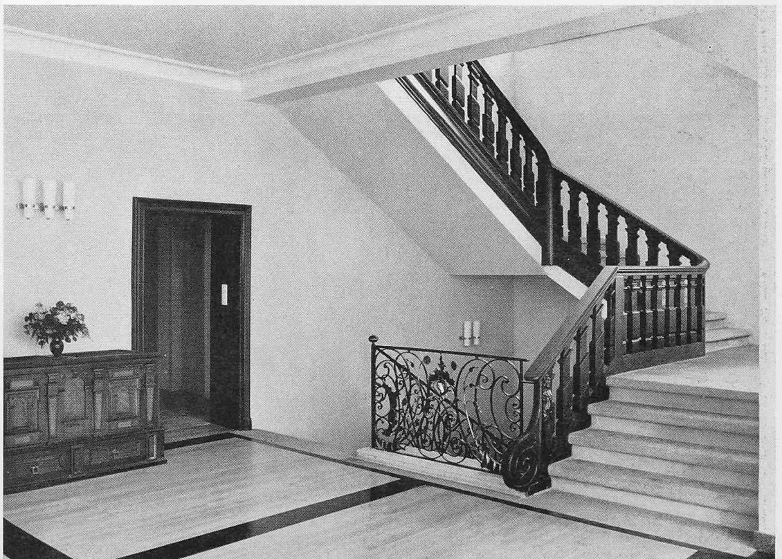
Treppe 1. Stock 1964. Neue Kalksteinstufen, Holzgeländer Eiche von 1685. Geschmiedetes Rokokogeländer von 1762 (ergänzt)
