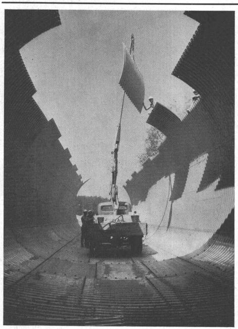
RMCO Multiplate-Rohre Entnahmetunnels, Silos
