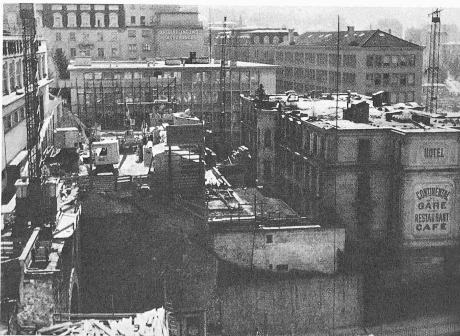
Bild 1. Hotel Continental, Lausanne. Arbeitsplanum für die Erstellung der bergseitigen Schlitzwand, System bentag. Blick nach Osten
