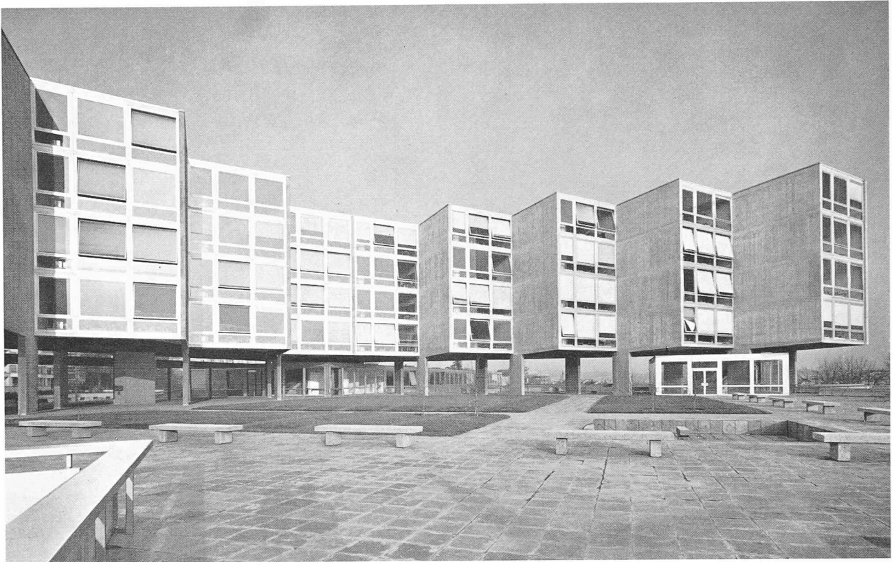
Blick aus Westen in den Hofraum (im Hintergrund zwischen den Stützen der Osttrakt)
