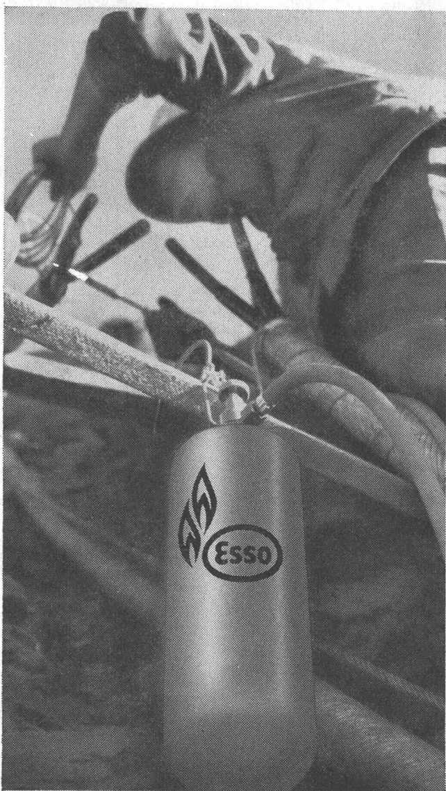
Kabelverlegung an der Schilthornbahn auf 2974 m.ü.M.
