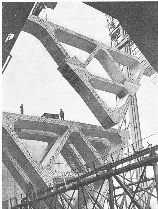
Bild 29. Osterscheldebrücke, Holland. Hohlkastenstücke wurden an stählerne Fachwerkbrücke angehängt und zusammengespannt
