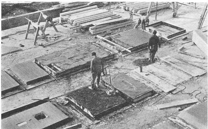
Plattenherstellung auf der Kellerdecke von Block F
