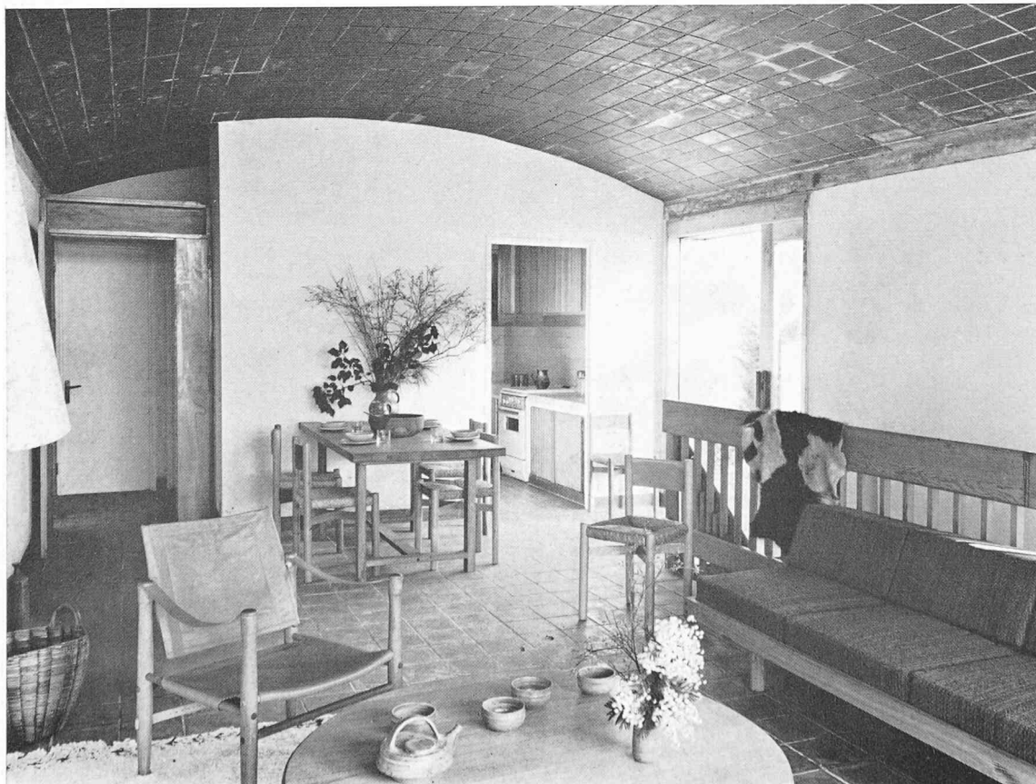
Wohnraum. Blick gegen die Küche. Der Boden und die gewölbte Decke sind mit Tonplatten belegt
