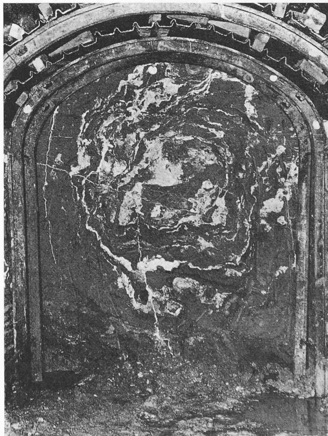
Bild 5. Chemische Injektionen im Kabelstollen PTT-Bern, Ansicht der Stollenbrüst
