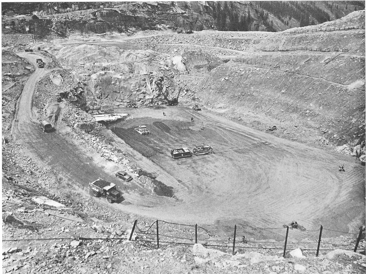
Bild 5. Der Kerneinbau in der bis auf den Fels ausgehobenen Baugrube des Staudammes Göschenentalp
