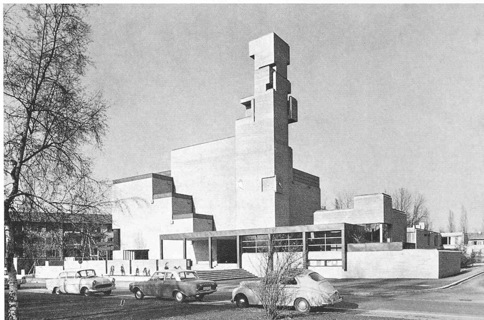
Kirche Saatlen, Zürich-Schwamendingen, Saatlenstrasse Bauherr: Reformierte Kirchgemeinde Zürich-Schwamendingen Architekt: Claude Paillard in Atelier CJP (Fred Cramer, Werner Jaray, Claude Paillard und Peter Leemann)
