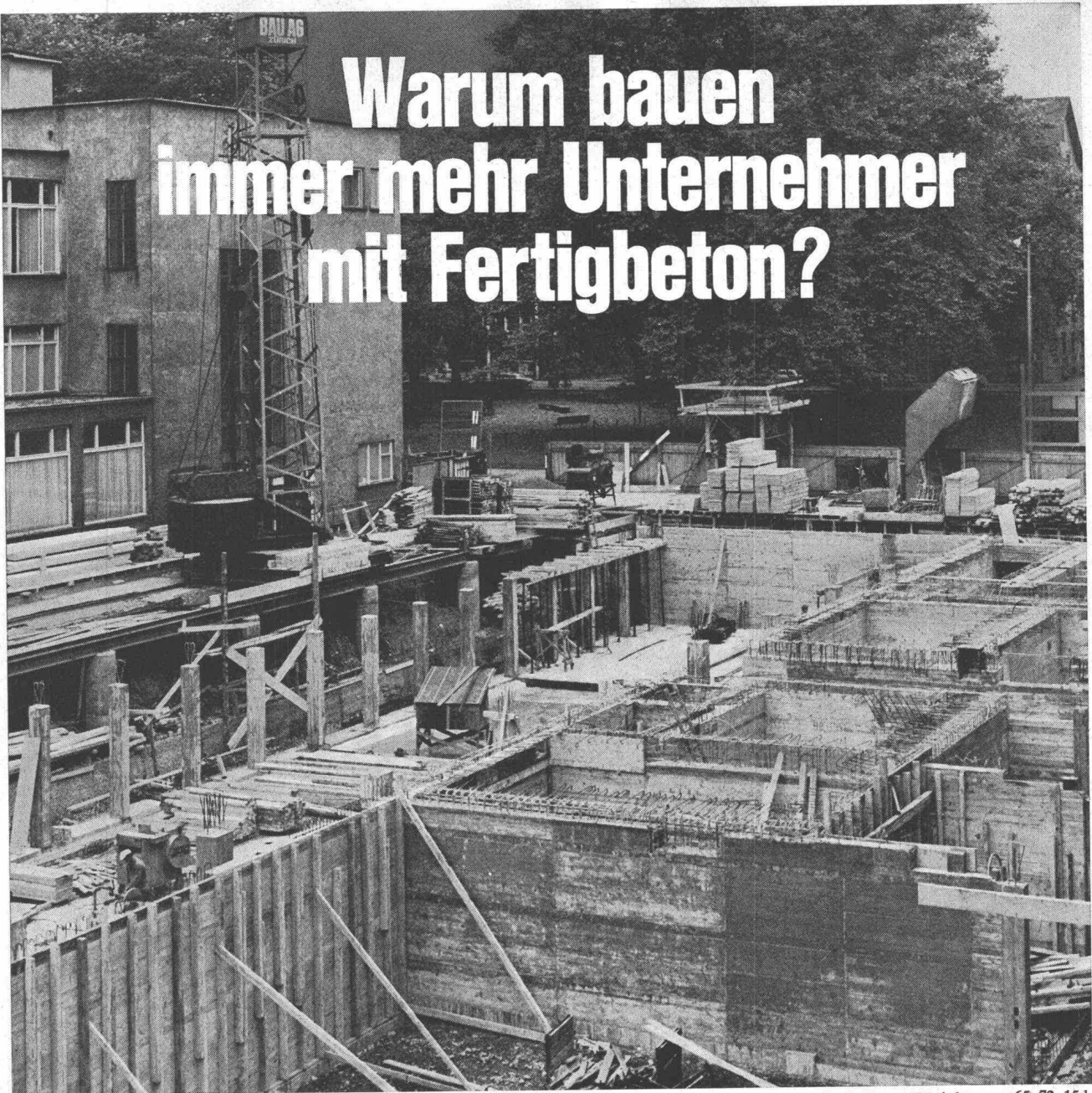
Erweiterungsbau Gewerbeschule der Stadt Zürich. Bauunternehmung: Bau AG für Hoch- und Tiefbau, Zürich 65. 72. 15d.
